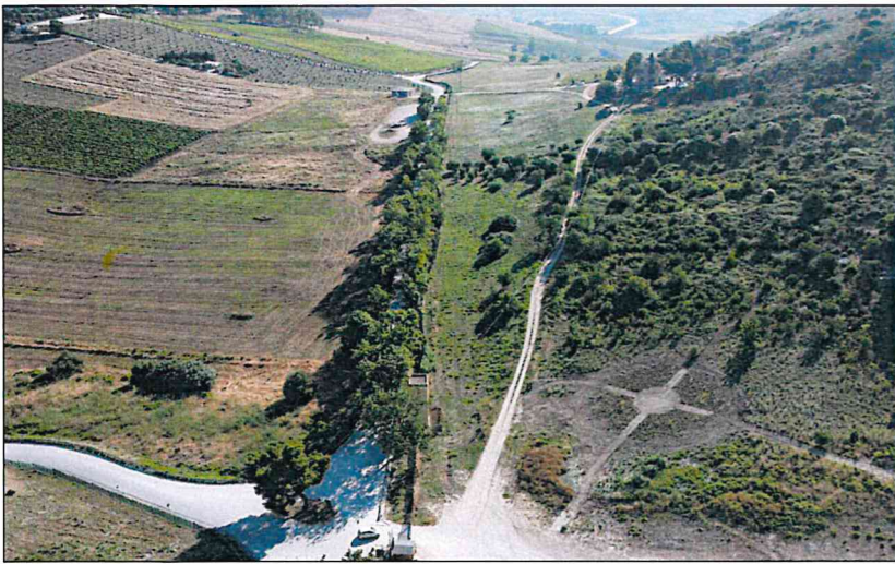
FOTO 1_ VISTA GENERALE AREA DI PROGETTO DAL LATO DELL' ACCESSO
