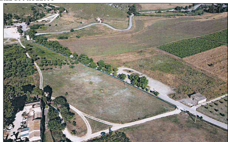
FOTO 4_ VISTA GENERALE DELL'AREA DI PROGETTO DAL LATO DI USCITA
